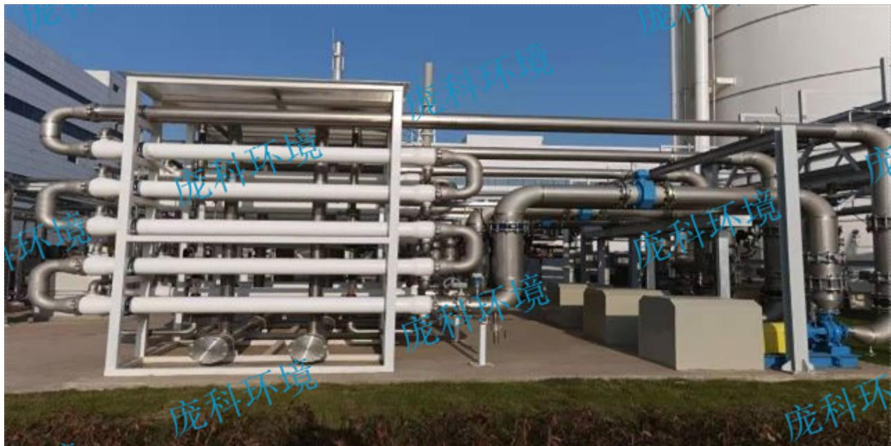
高负荷好氧脱氮膜反应器作用特点：1、塔式的AO生化系统，负荷高，占地少；2、系统设备少，故障率低，外置式膜美观整洁，便于维护；3、自控化程度高，操作简单，配备人工少；4、可实现氨氮、总氮去除的同时，又实现胶状COD的去除，取得更好的出水水质；5、罐体式设计，可全密闭，避免废气排放，更加友好的周边环境；6、出水不含悬浮物，水质清澈透明，便于进一步深度处理或回用。高负荷好氧脱氮膜反应器是通过泵将生化池内的污泥-水混合液直接打入超滤膜内，在压力的驱动下进行固液分离，透过膜的清水进入产水箱或直接排放，而浓液再次回到生化池继续参与生化反应的一种生物反应器。
