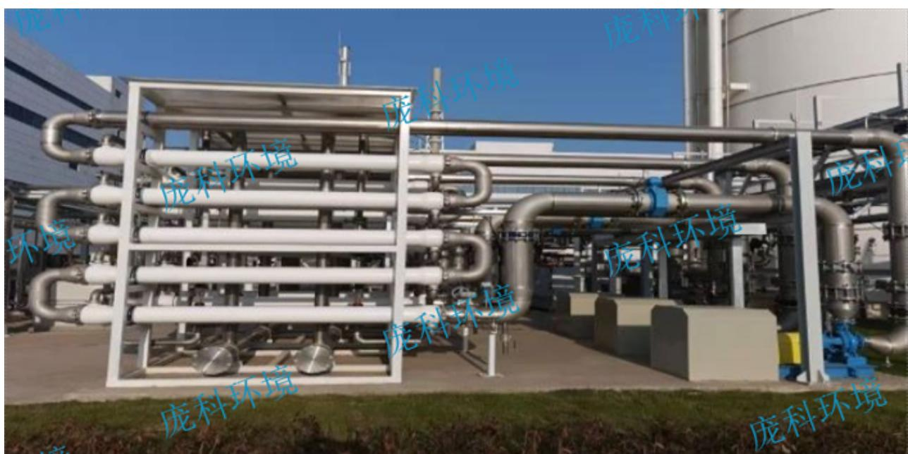
污水反硝化脱氮处理是指利用反硝化细菌将水中硝酸盐氮还原成氨氮并进而将其去除的废水脱氮处理过程。污水反硝化脱氮处理是指利用反硝化细菌将水中硝酸盐氮还原成氨氮并进而将其去除的废水脱氮处理过程。反硝
